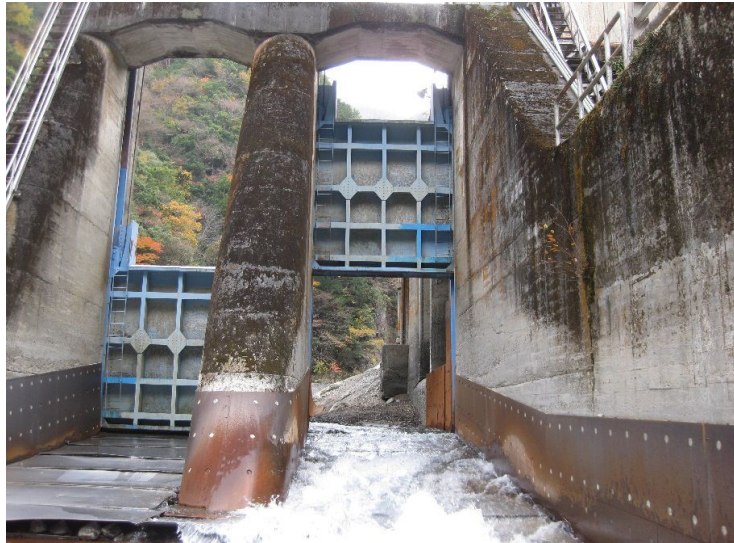
排砂ゲート背面
