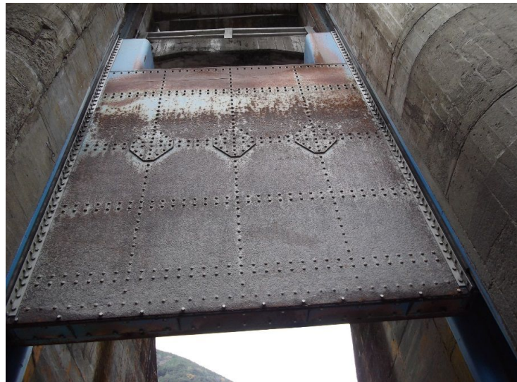
排砂ゲート正面
